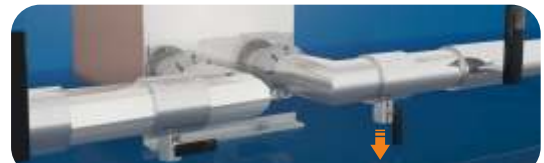
Stoppen Sie die CIP-Maschine. Lassen Sie die Reinigungsflüssigkeit aus dem Wärmetauscher und der CIP-Maschine ab.
