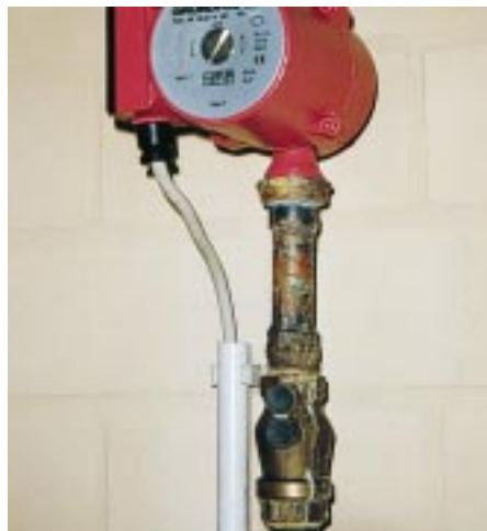
Sieht aus wie „Grünspan“ oder Korrosion durch Flußmittelrest. Die weißlichen Ausblühungen an den Verschraubungen lassen aber auf elektrisch bedingte Korrosion schließen [2]
