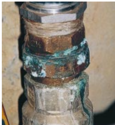
Sieht aus wie „Grünspan“ oder Korrosion durch Flußmittelrest. Die weißlichen Ausblühungen an den Verschraubungen lassen aber auf elektrisch bedingte Korrosion schließen [2]
